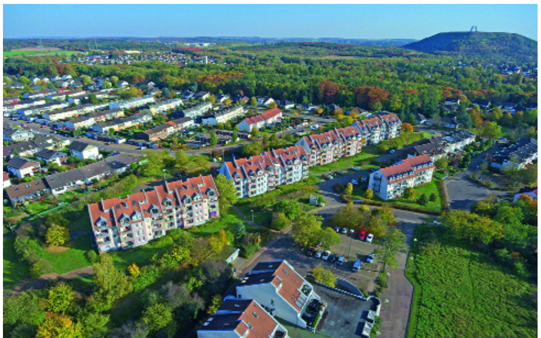
Luftaufnahme Wohngebäude Thomas-Mann-Straße
